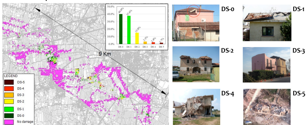
Fig. 1: Rilievo del danno a seguito del tornado della Riviera del Brenta 2015.
